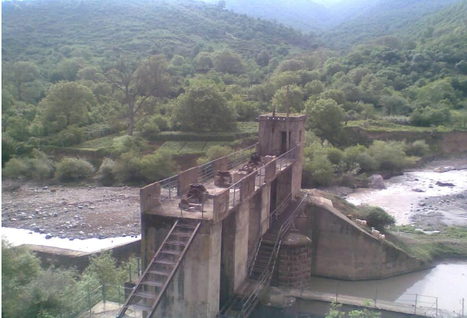
Şəkil 2.4: Zurnabad HES-n sugötürücü qurğusu
